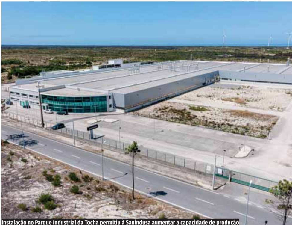
Instalação no Parque Industrial da Tocha permitiu à Sanindusa aumentar a capacidade de produção
